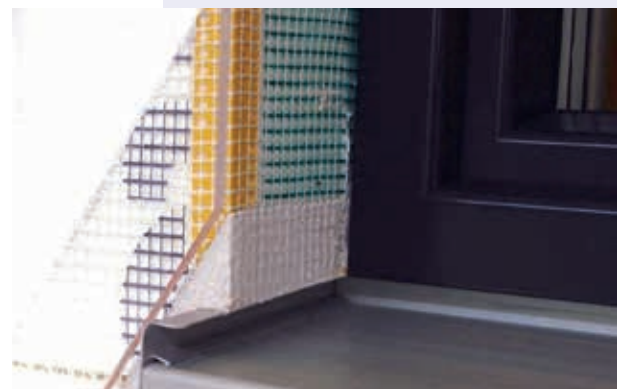
Dämmung der Fensterlaibung bei einer Wärmeschutzfassade
