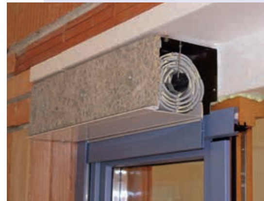
Wärmebrückenfreier Einbau eines Rollladens
