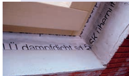
Luftdichter Einbau mit Glatzstrich und Klebefolie
