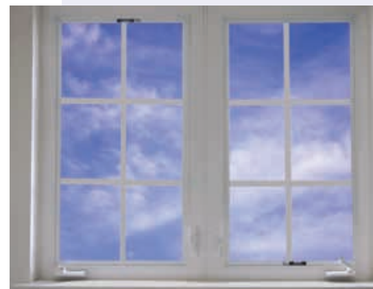
Fenstersprossen werden nur aufgesetzt und sollten das Glas nicht teilen.
